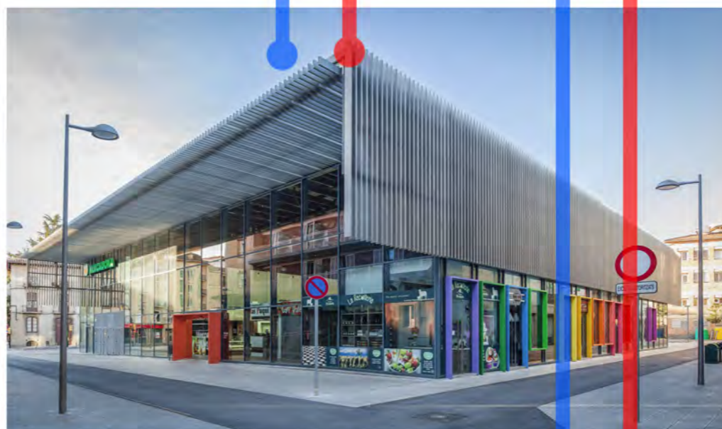
PLAZA DEL MERCADO Calor a alta temperatura y frío Calefacción y aire acondicionado
