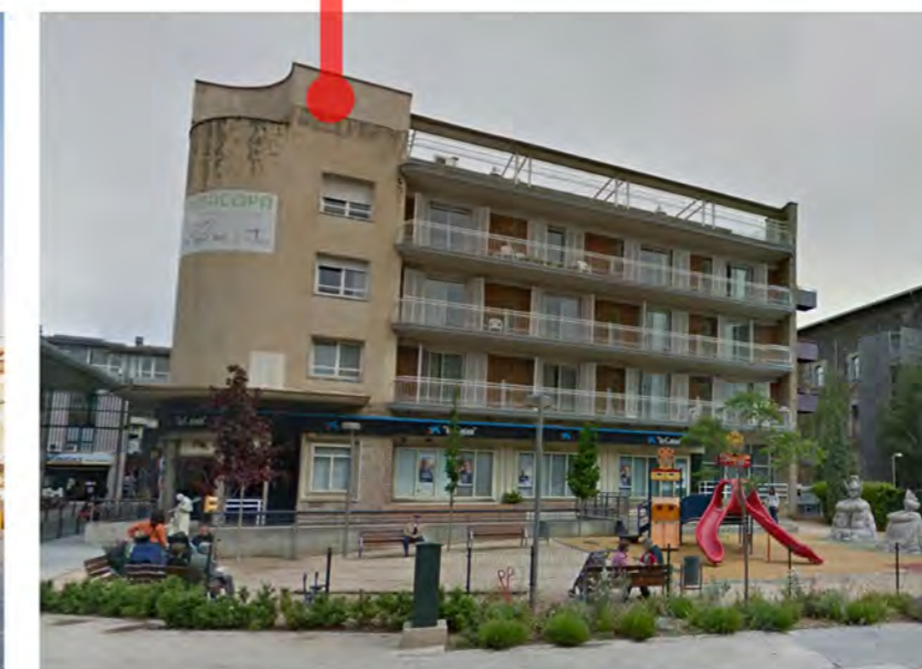
RESIDENCIA GERIÁTRICA MONTSACOPA Calor a alta temperatura ACS y calefacción
