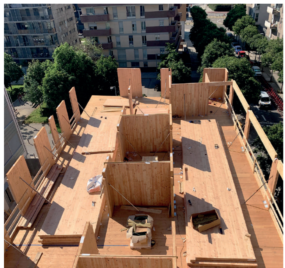
CONSTRUCCIÓN DE ESTRUCTURA CLT
