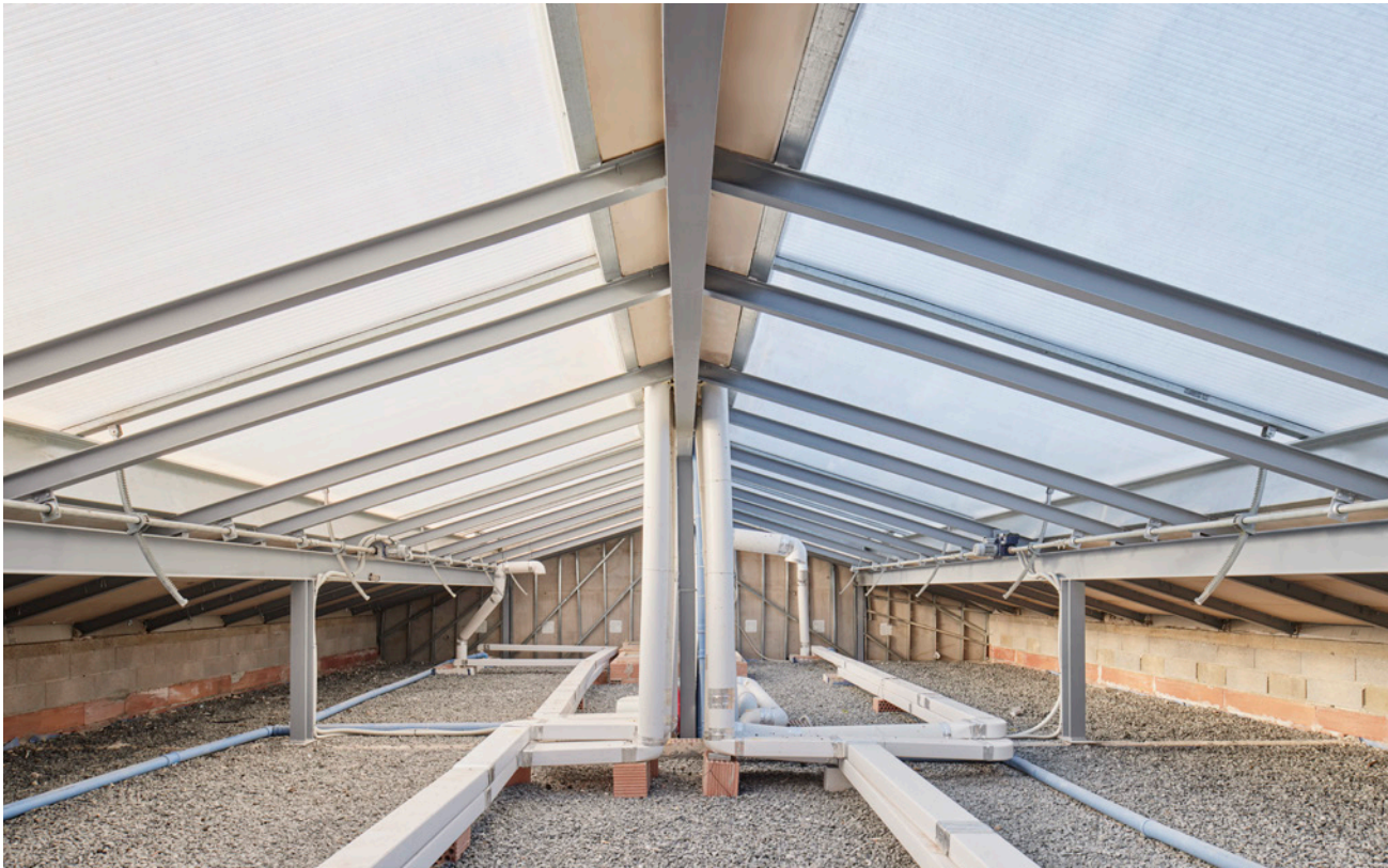
LA CUBIERTA TROMBE: INVERNADERO, RECUPERADOR Y CHIMENEA
