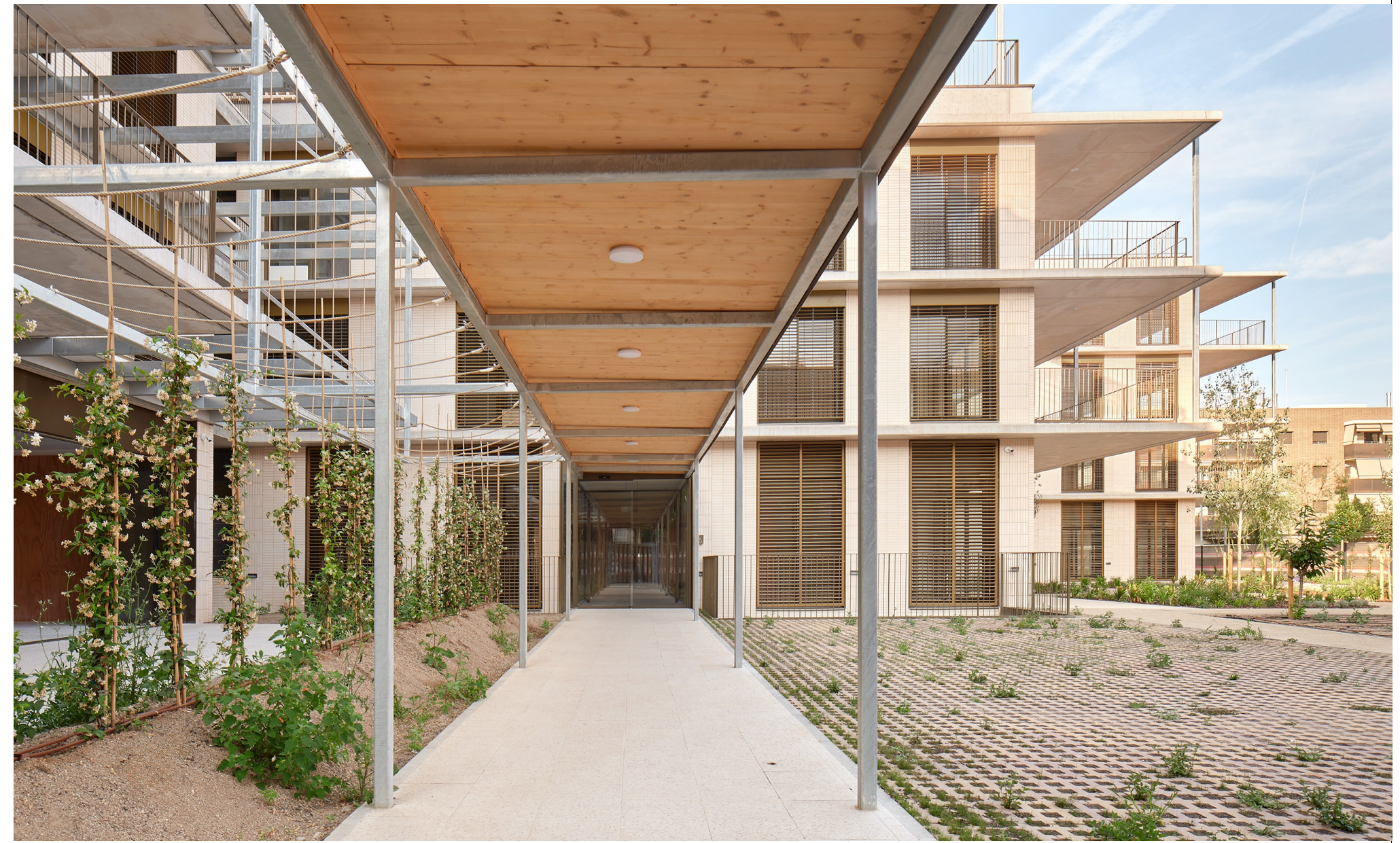
ACCESO: Acceso de residentes, centro de día (izquierda) y drop-off (derecha). Estructura de la marquesina de madera contralaminada.
