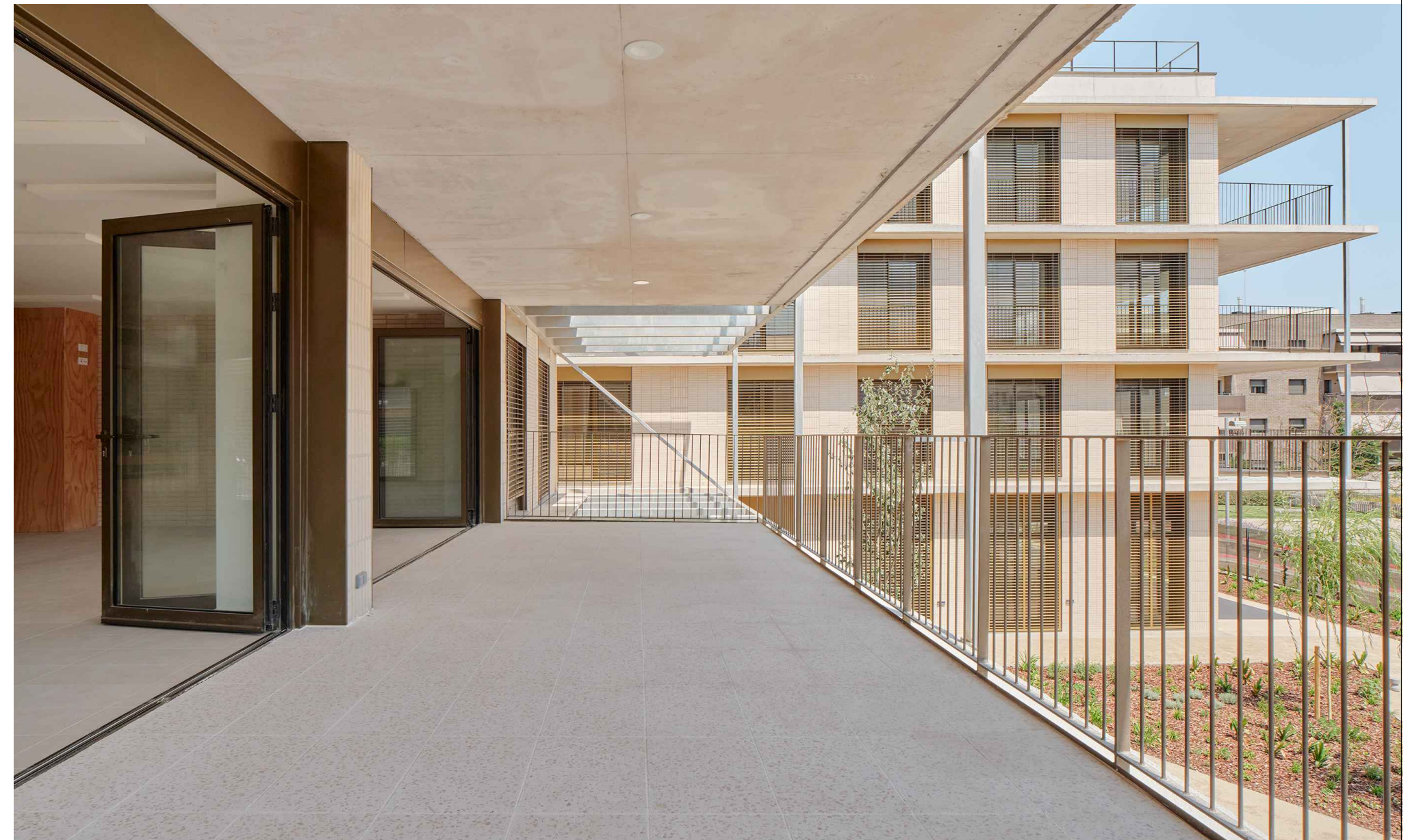
TERRAZA: Espacio exterior en relación a la sala de estar y comedor orientado a sur.
