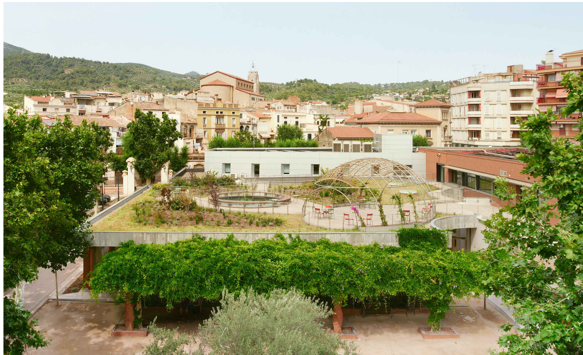
EMPLAZAMIENTO: Ampliación de la biblioteca en relación con la existente a la derecha y la casa de la cultura al fondo.
